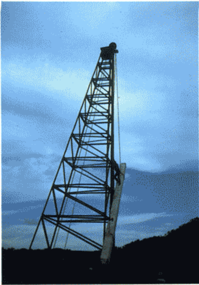
เสาเข็มไมโครลิฟท์สำหรับใช้ชั้นลงบันจัน การขึ้นบนเสาเข็มขณะยกนับว่าอันตรายมาก
