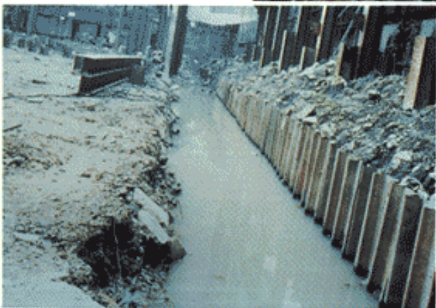
แสดงการป้องกันภัยทุกชนิด นับตั้งแต่ตอก Sheet Piles, ชุดคู ซิงค์ไบบ์ ใช้ปลอกเหล็ก
