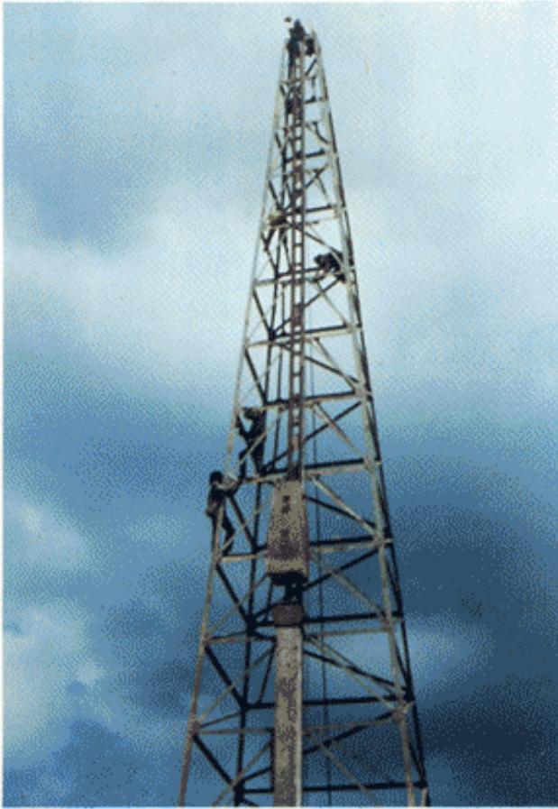
การปีนป่ายชั้นสลักเกลียวในขณะกำลังตอกเสาค้ำเช่นนี้อาจเกิดอันตรายได้ง่าย
