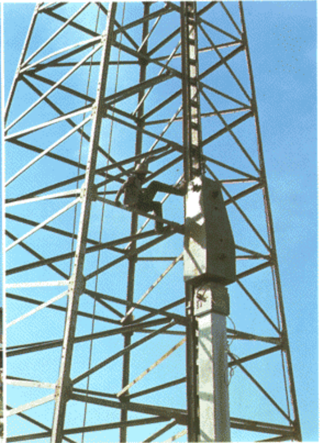
การใช้เท้าหรือมือดันสลักไม่ให้หลุดในขณะที่ตอกเป็นสิ่งที่ไม่ควรกระทำ ควรหาวิธียึดจะดีกว่า
