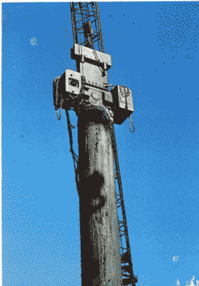
การลงบล็อกเหล็กชั่วคราว สำหรับป้องกันดินพัง
