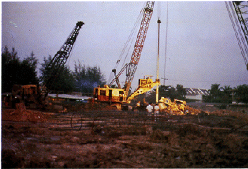
ปั้นจั่นชนิดขับเคลื่อน (Mobile Crane)
