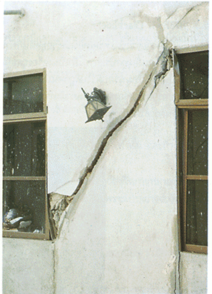
แม้จะป้องกันอย่างดีแล้วก็ตาม แต่ถ้ายังไม่ดีพอ บางครั้งถึงกับอาคารข้างเคียงวิบัติได้
