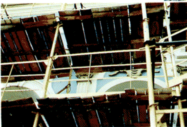
นั่งร้านที่ติดตั้งต้องแข็งแรง และแผ่นกระดานยึดติดแน่นกับโครงเหล็ก
