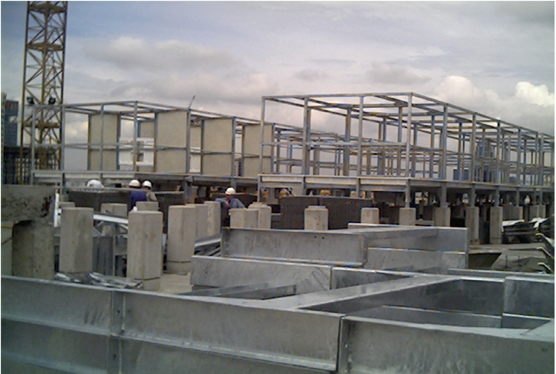
การติดตั้งโครงเหล็กกับ Casing
