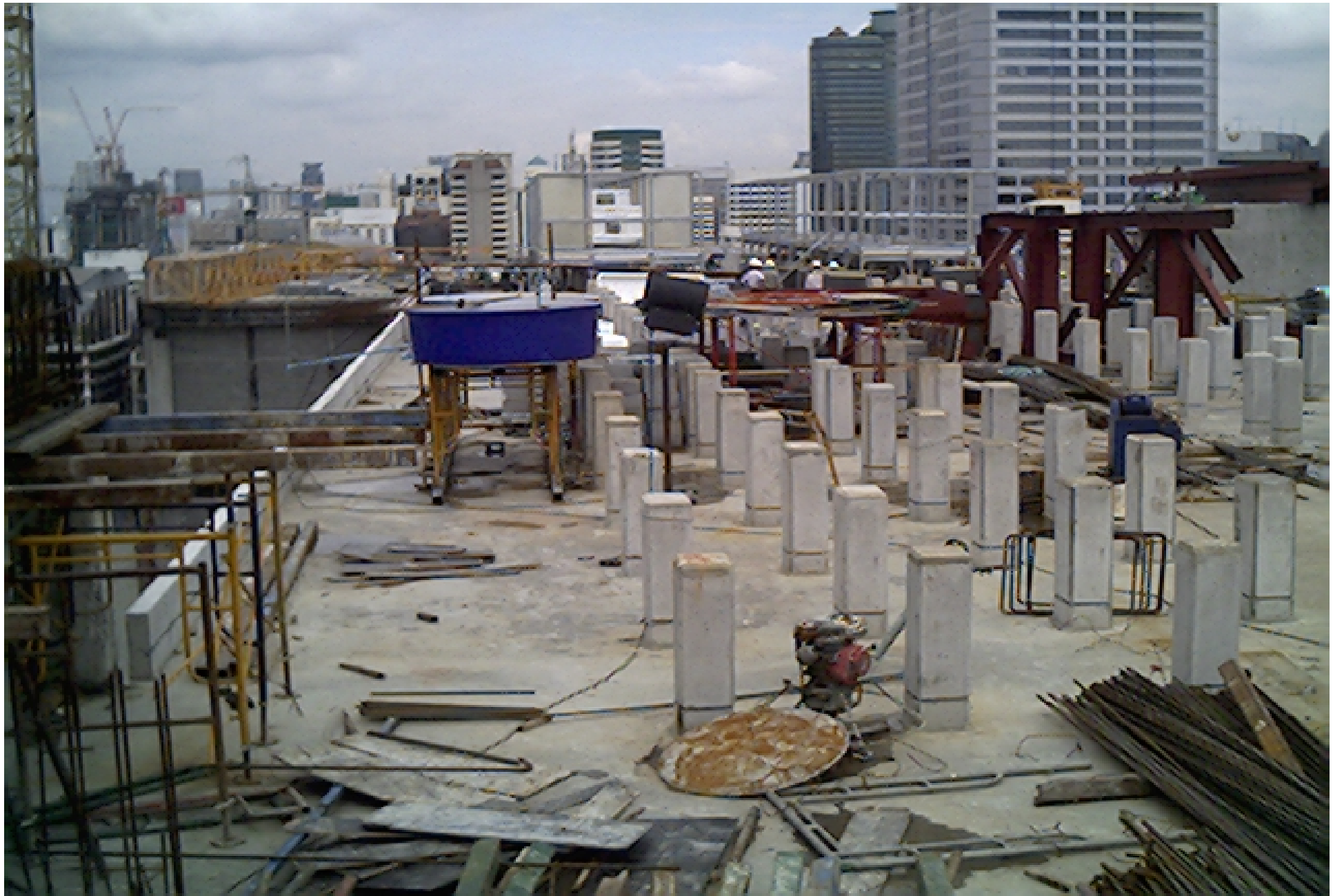
แท่น Concrete ฐาน Cooling Tower
