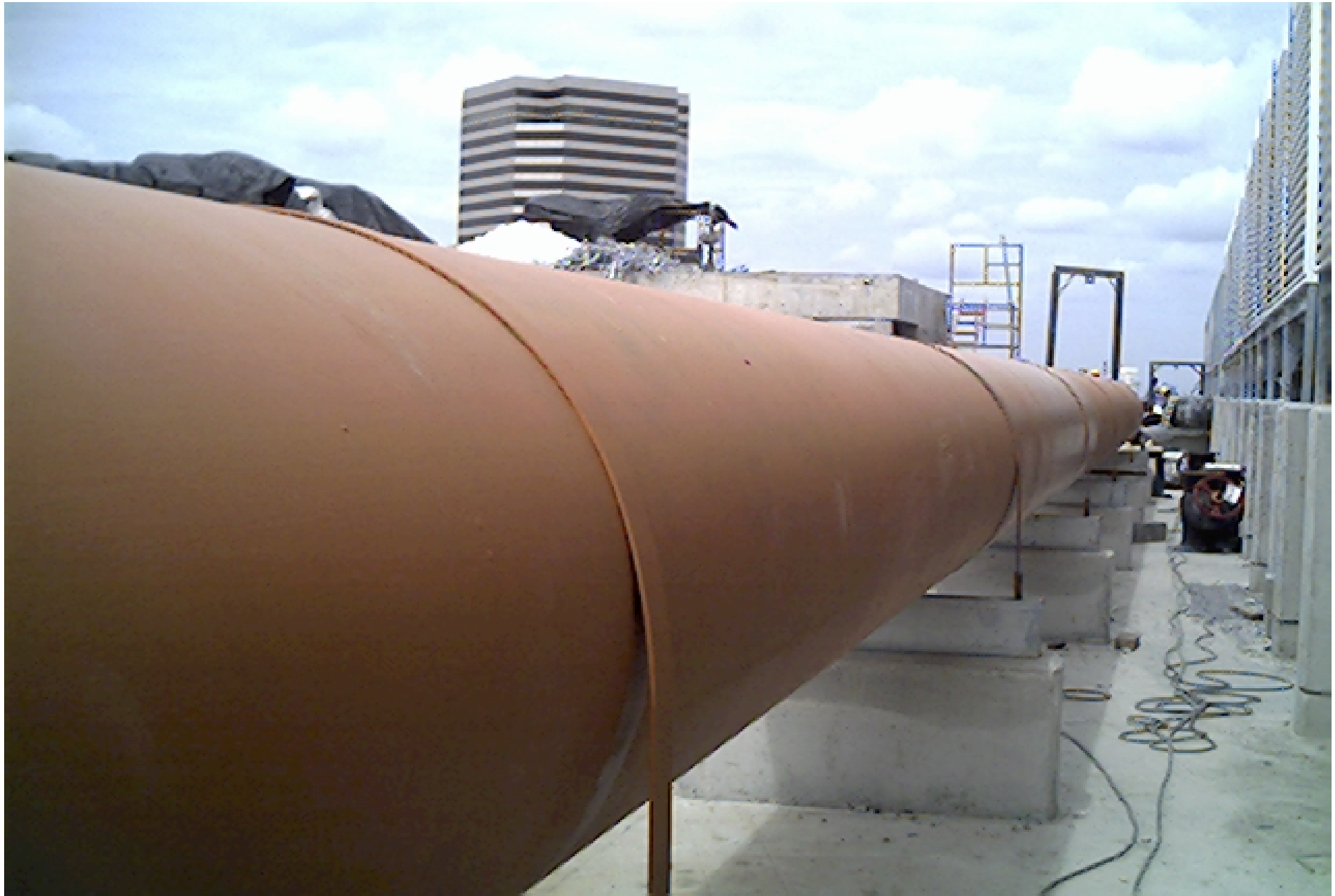
การติดตั้ง Support ยึดท่อน้ำ
