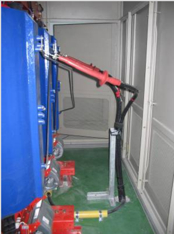
การต่อสายแรงสูง เข้าหม้อแปลง แบบ BOLT ON
