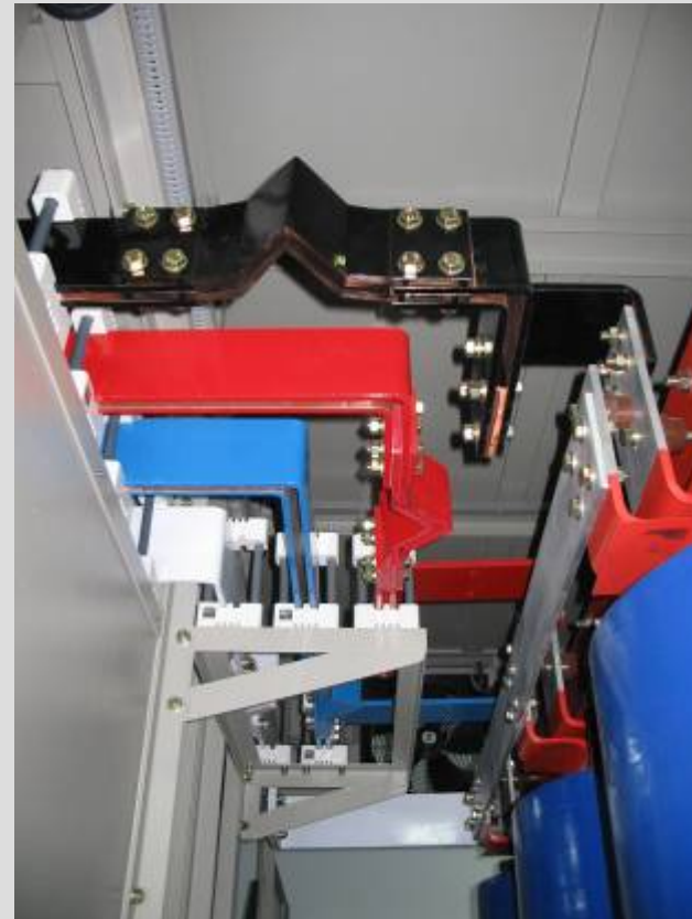
การต่อ FLEXIBLE BUSBAR
